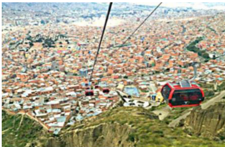
Fotografía 3. Línea Roja del Sistema de Teleférico entre El Alto y La Paz, Estado Plurinacional de Bolivia
